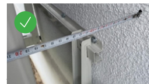
Après remise en conformité
